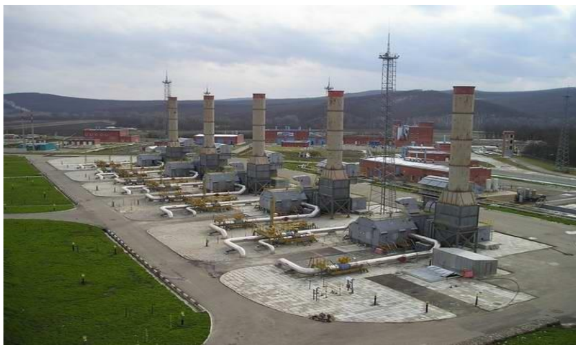
2 сурет – Газотурбинді жетегі бар, ГАА орналастырылған КС-ң жалпы көрінісі
